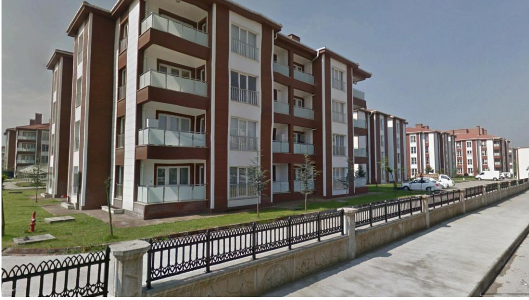
Şekil 1. 22. Camikebir Mahallesiinde Kentsel Dönüşüm Kapsamında İnşa Edilen Toki Konutları
