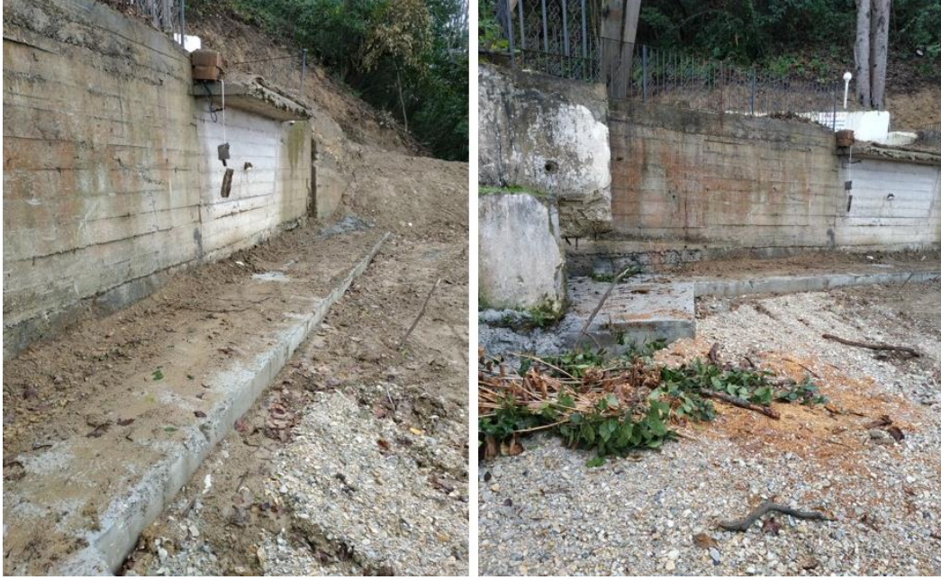
Şekil 1. 25. Bolu Güneş Sitesinde Yapılmış Heyelan Önleme İksa Yapısı (Betonarme İstinat Duvarı)
