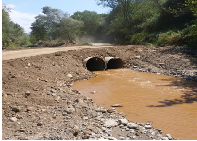
Şekil 1. 32. Düzce İli sınırlarından geçen derelere yapılan müdahaleler (Asarsuyu Deresi)
