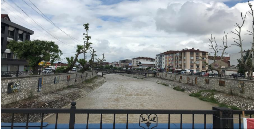
Şekil 1. 29. Düzce İli derelerindeki taşkın koruma tesisi örnekleri (Asarsuyu Deresi)
