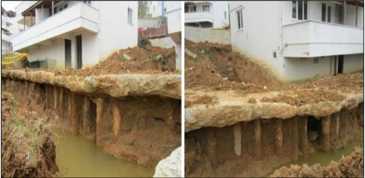
Şekil 1. 27. Afete Maruz Bölgenin Kuzeydoğu Sınırı Boyunca Yapılmış Çift Sıra Fore Kazık Sistemi
