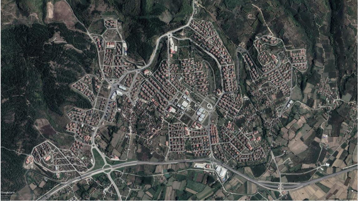
Şekil 1. 20. Düzce Merkez Bahçeşehir Semtinde İnşa Edilen Konutların Google Earth Görüntüsü
