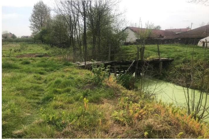
Şekil 1. 34. Düzce İli sınırlarından geçen derelere/kanallara yapılan müdahaleler (Hacıkadırlar Köyü)
